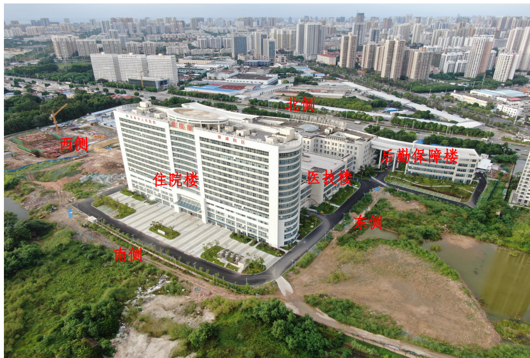
图 2 项目主体工程区东侧
