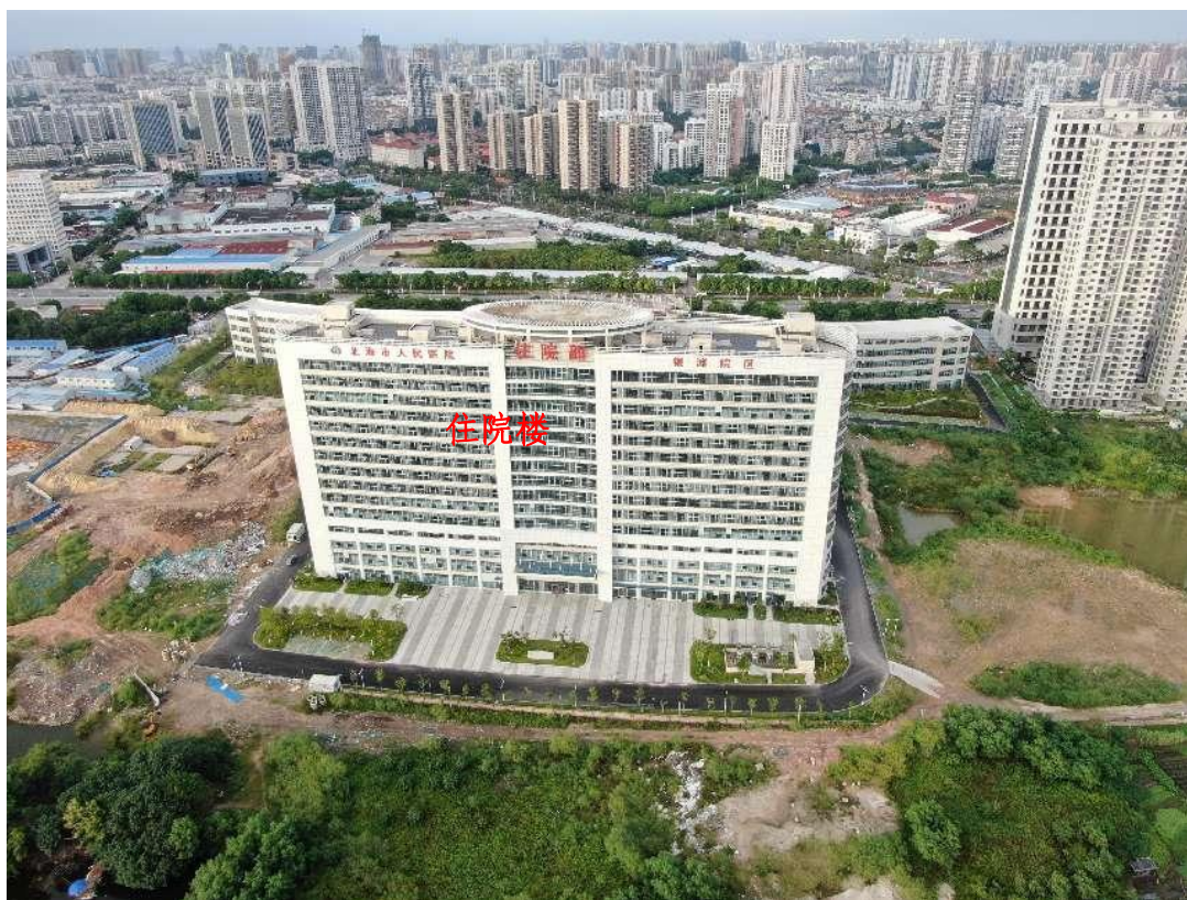
图 5 项目主体工程区南侧
