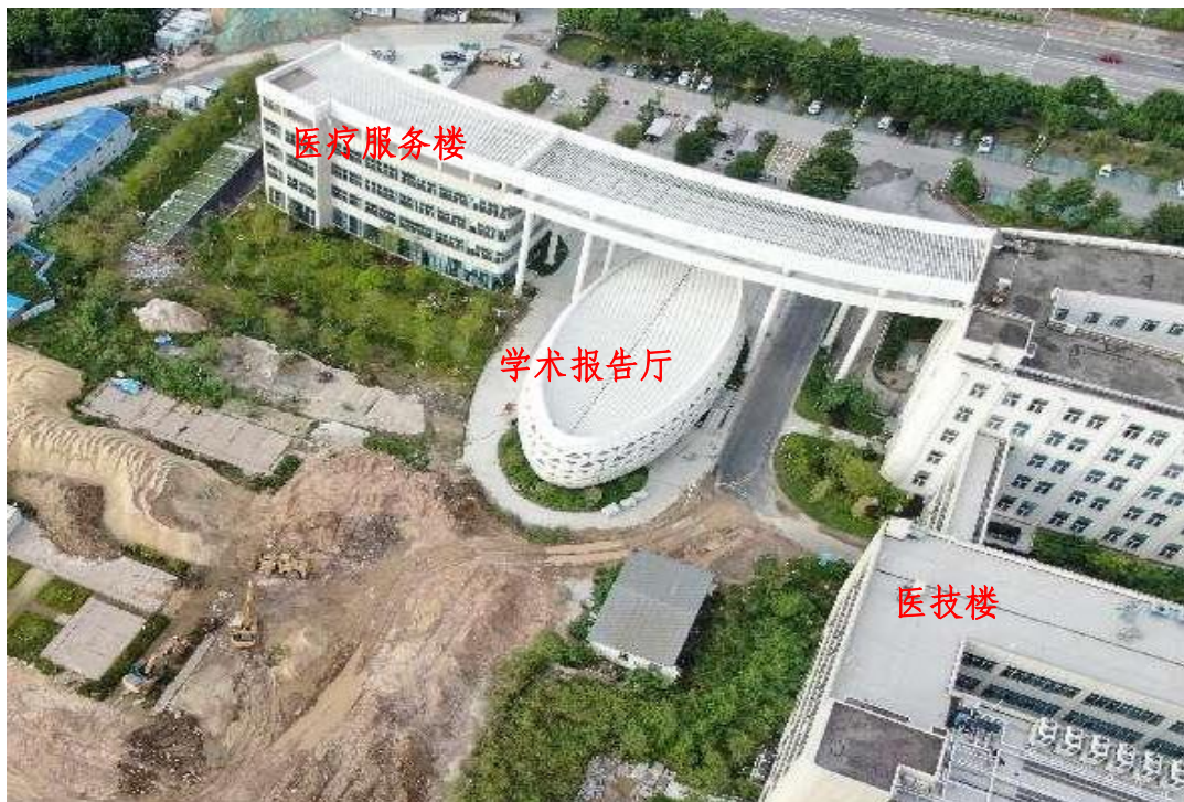
图4 项目主体工程区西北侧（学术报告厅、医疗服务楼）
