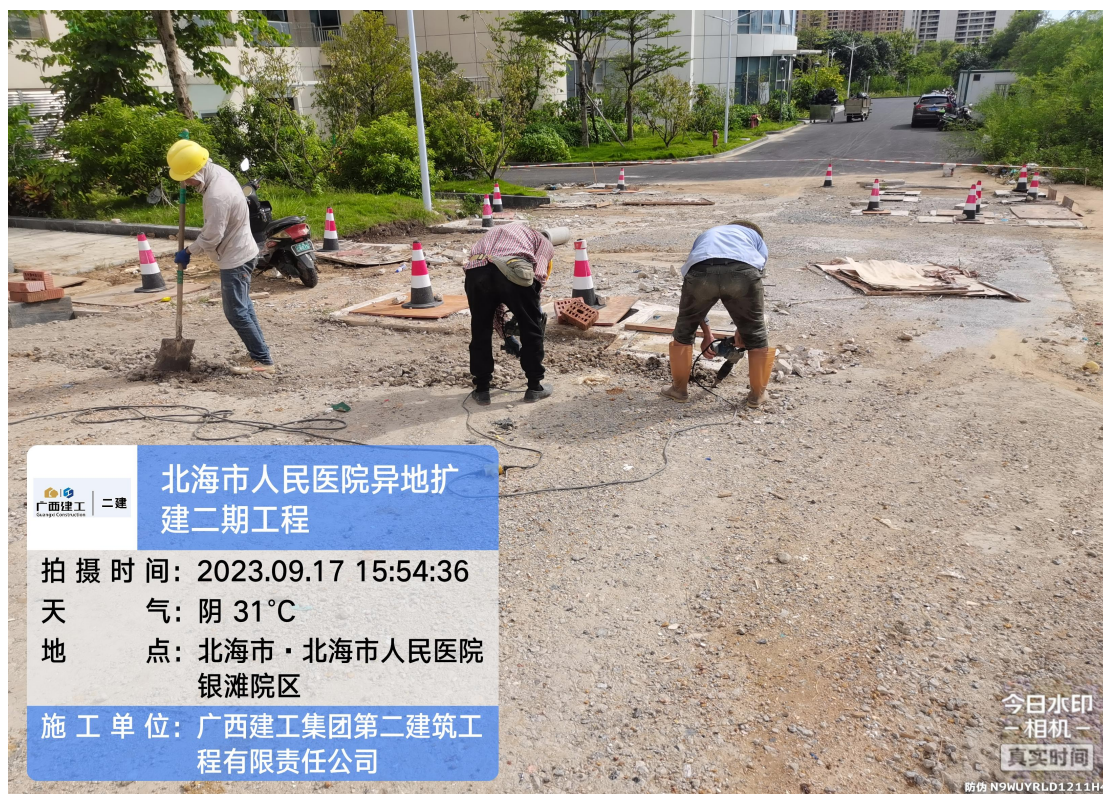
图 1 医技楼西侧道路场地平整
