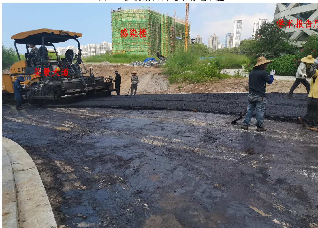
图 2 医技楼西侧道路路面硬化
