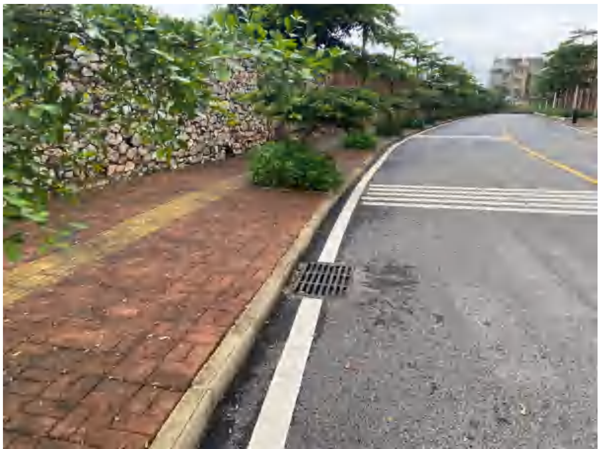
道路景观绿化、透水铺装、雨水排水工程现状图
