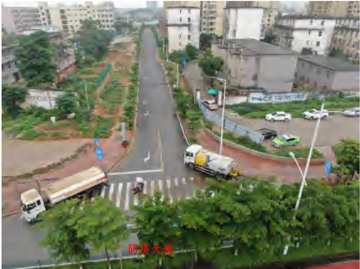
道路桩号 K0+025~K0+120 区段现状图
