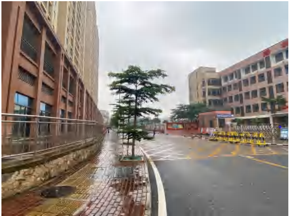
道路边界与安置小区衔接处现状图(一)
