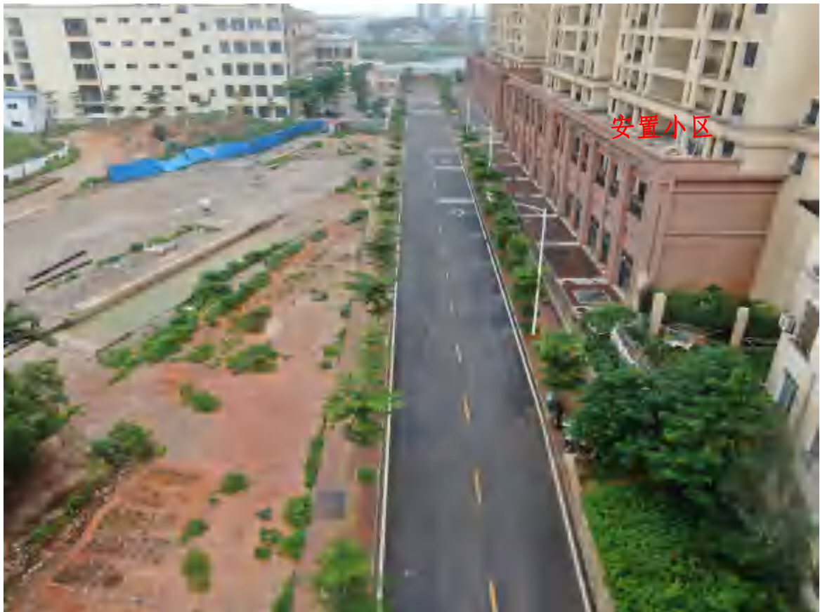
道路桩号 K0+120~K0+300 区段现状图
