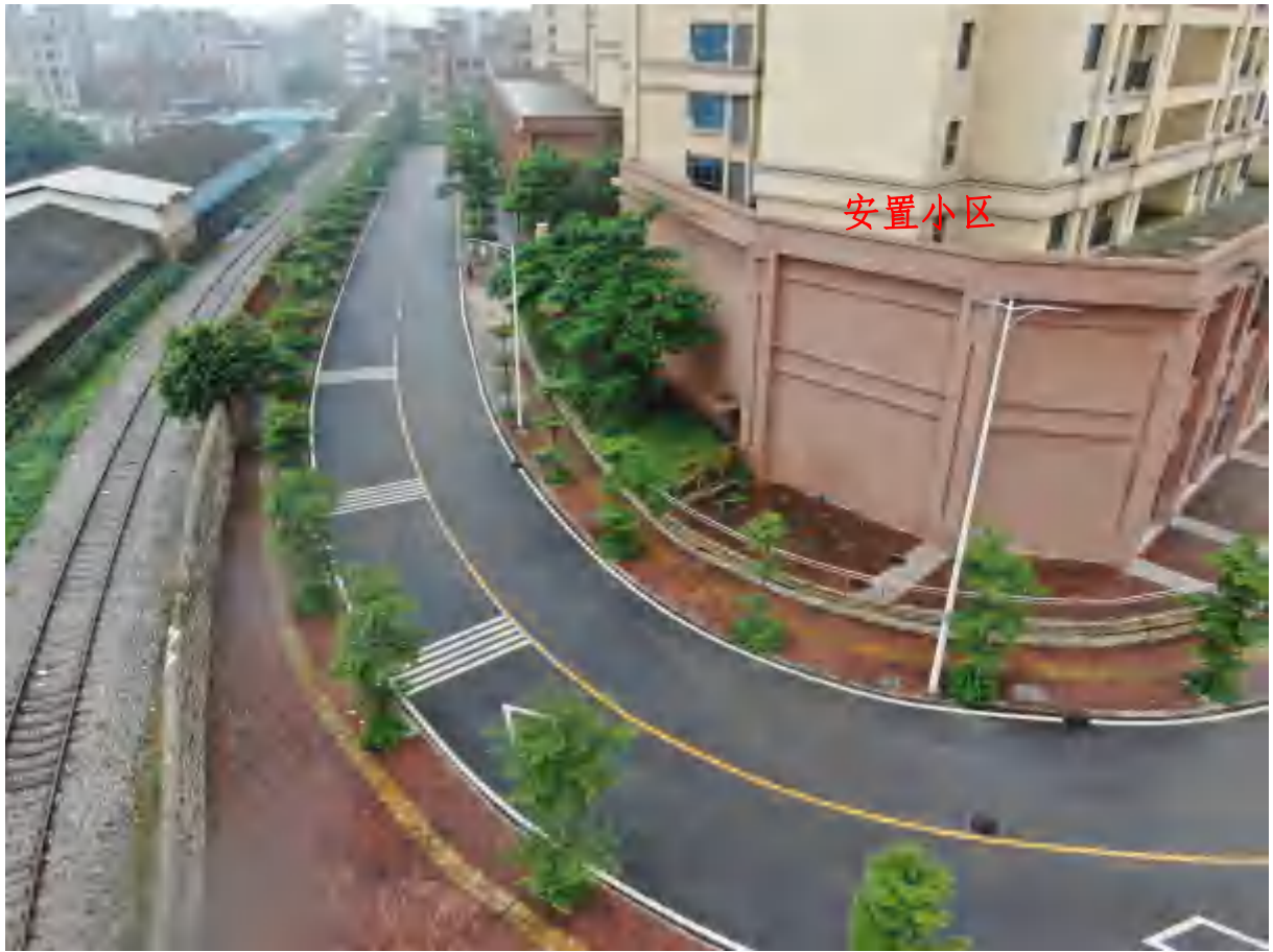
道路桩号 K0+300~K0+461.2 区段现状图
