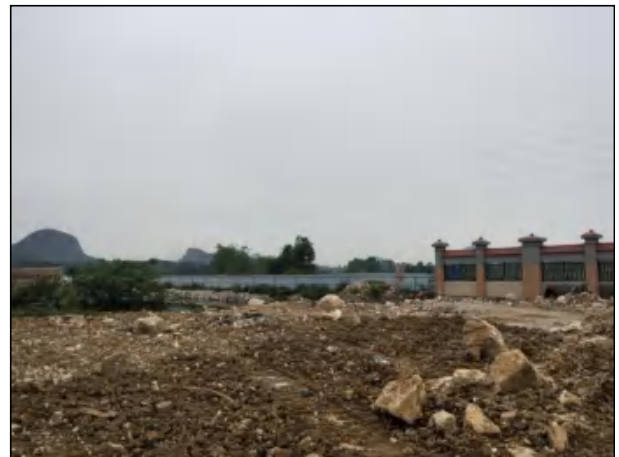
项目用地内裸露地表现状，无临时覆盖措施
