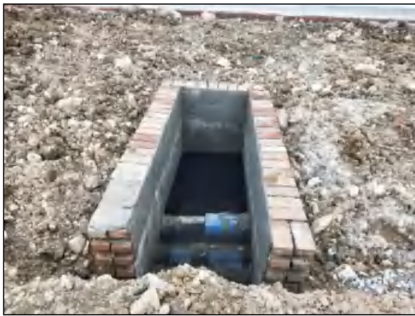
项目用地内雨水井因无法外排积水现状
