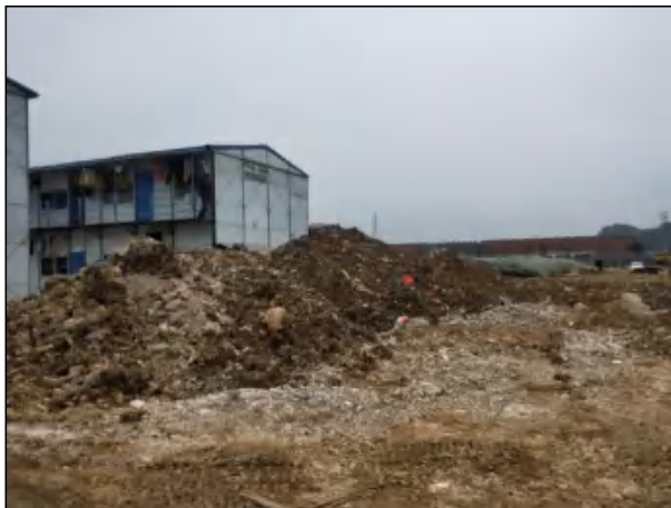
项目用地内堆土现状，无临时覆盖措施
