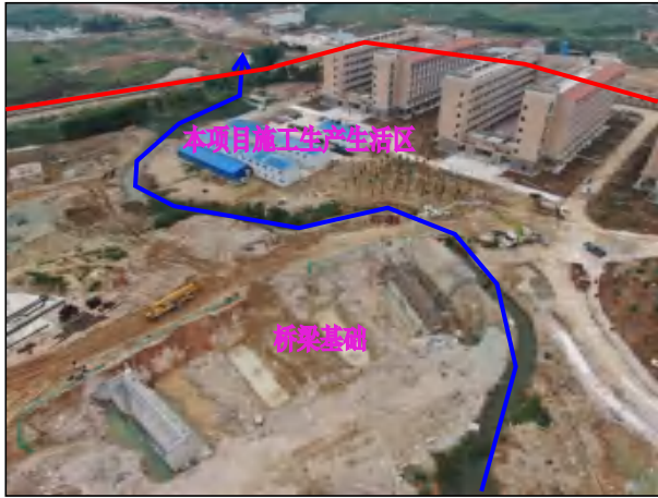
项目用地内中部跨大冲塘桥梁建设现状
