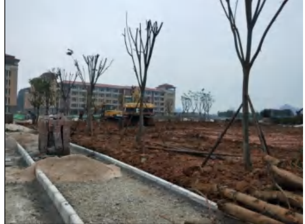
项目用地内景观绿化施工现状
