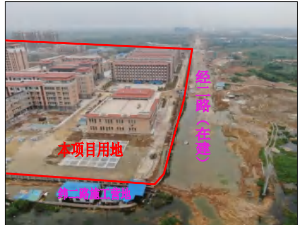
项目用地东南面现状，纬二路用地
