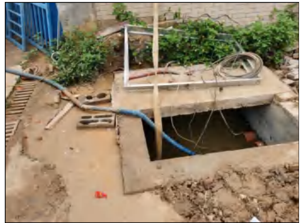
项目用地内雨水井因无法外排积水现状
