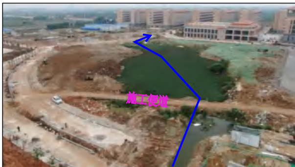
穿过本项目用地内的大冲塘河段中部现状，施工在该区设置 1 条施工便道，后期拆除交还河道用地
