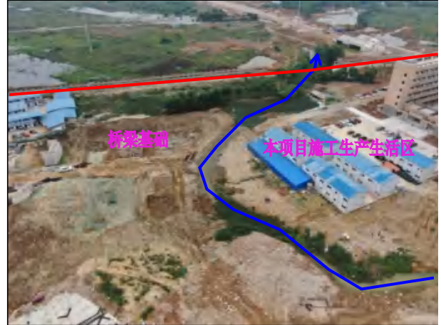
项目用地内北面跨大冲塘桥梁建设现状
