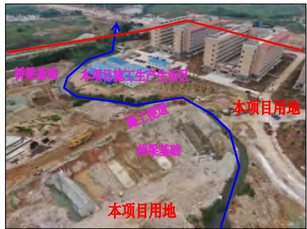
项目建设时在中部、北面跨大冲塘处设置2条施工便道，桥梁建成后，本项目拟对其进行拆除
