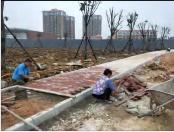
项目用地内铺透水砖现状
