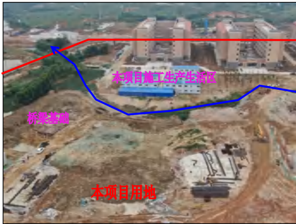
项目用地北面、东北面现状，开挖面较大，地面裸露，仅局部区域进行覆盖密目网
