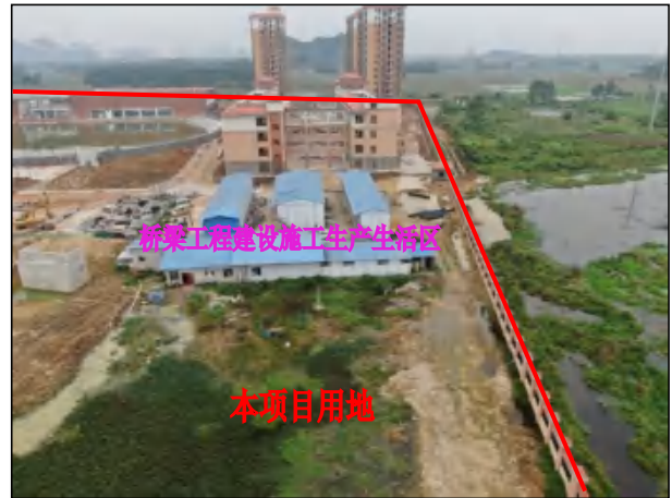
项目用地北面、东北面现状，开挖面较大，地面裸露，仅局部区域进行覆盖密目网
