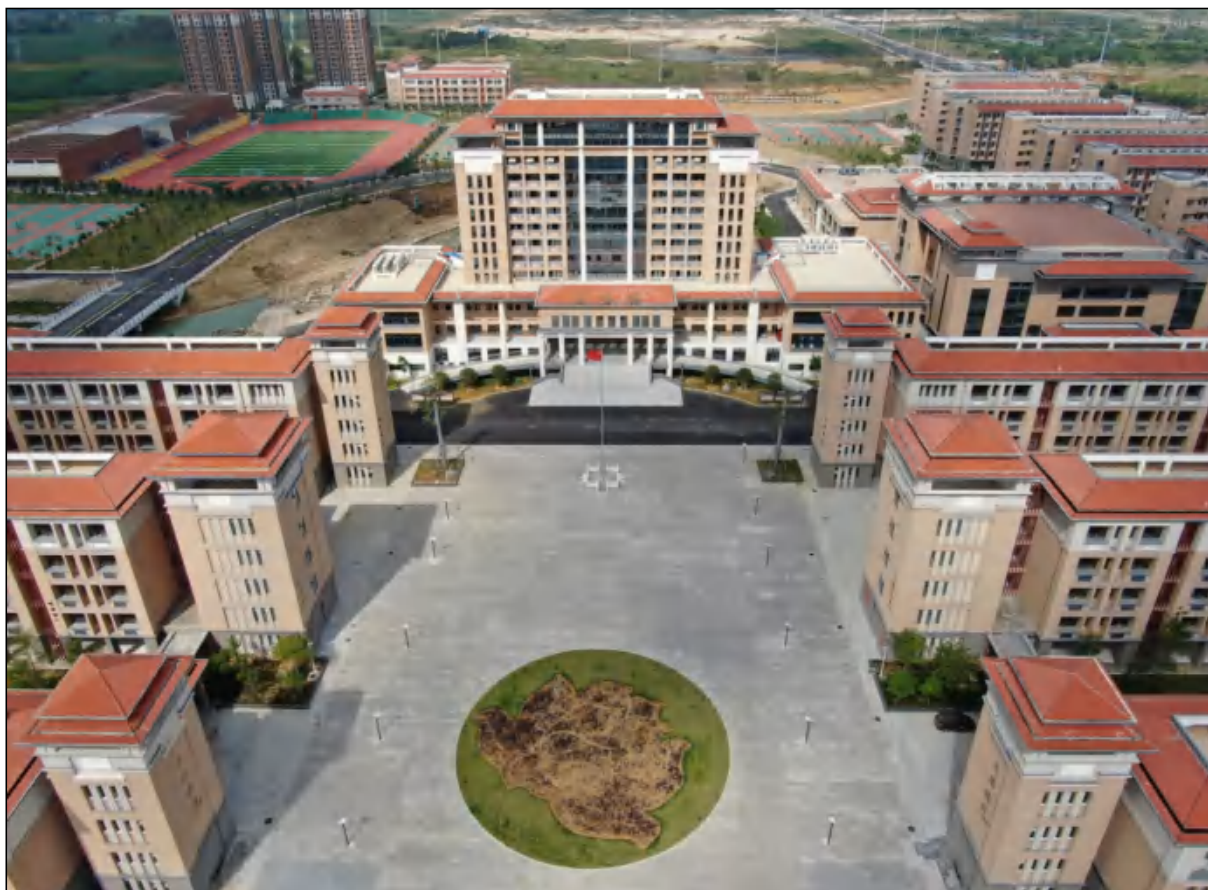
项目用地南面校园正门广场处现状，构筑物、附属设施等已全部建成
