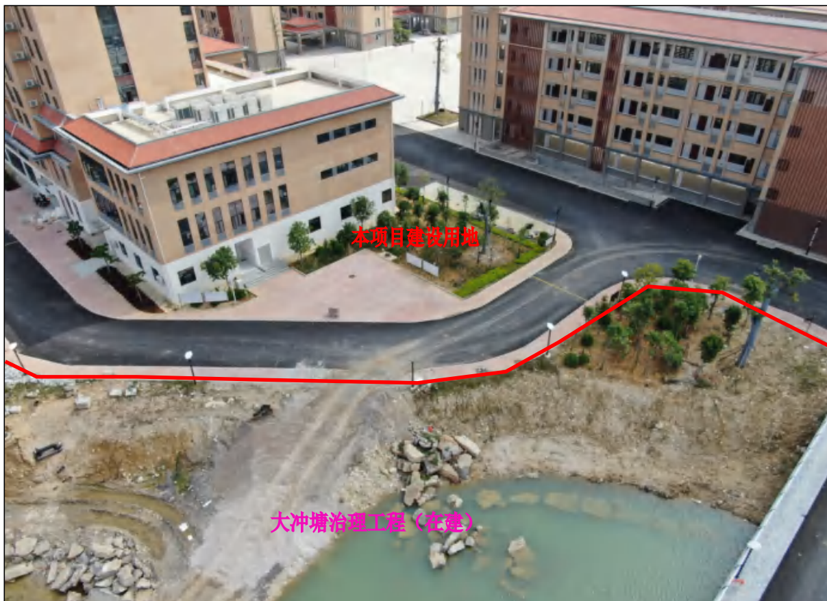
本项目用地与大冲塘治理工程用地衔接处中部现状，大冲塘治理工程现状施工阶段
