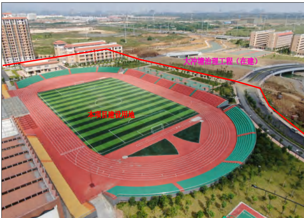
项目用地西北面体育场用地现状，构筑物、附属设施等已全部建成
