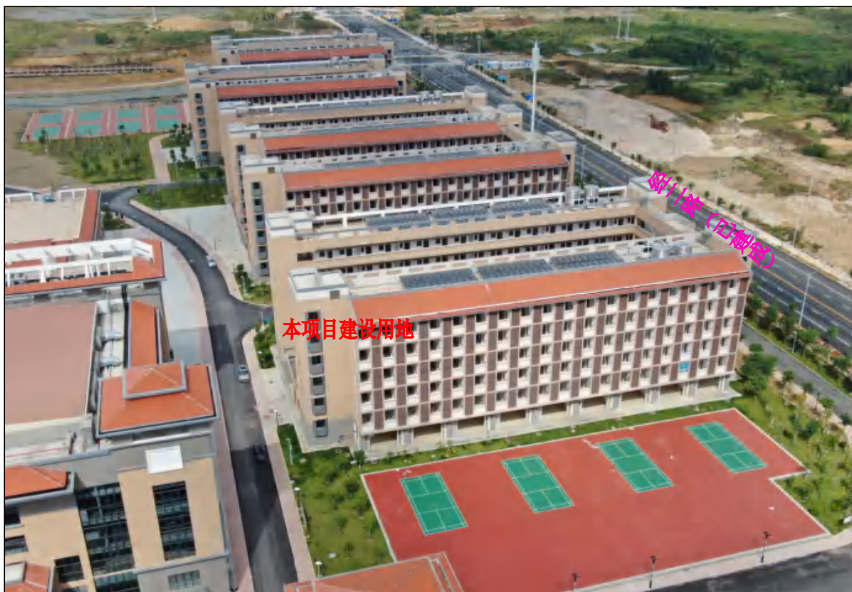
项目用地东面现状，构筑物、附属设施等已全部建成
