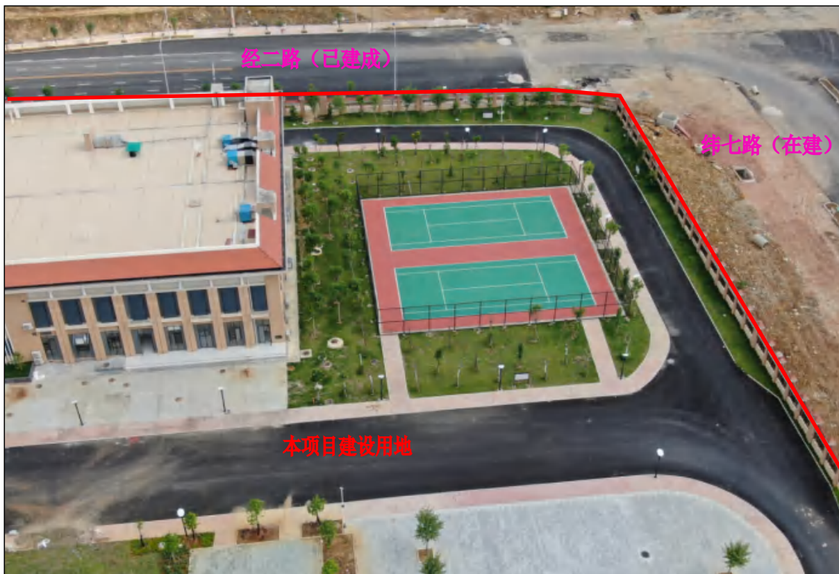
项目用地东南面现状，构筑物、附属设施等已全部建成，植被生长状况较好
