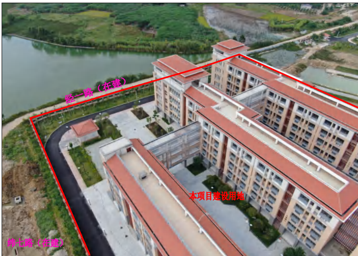
项目用地西南面现状，构筑物、附属设施等已全部建成
