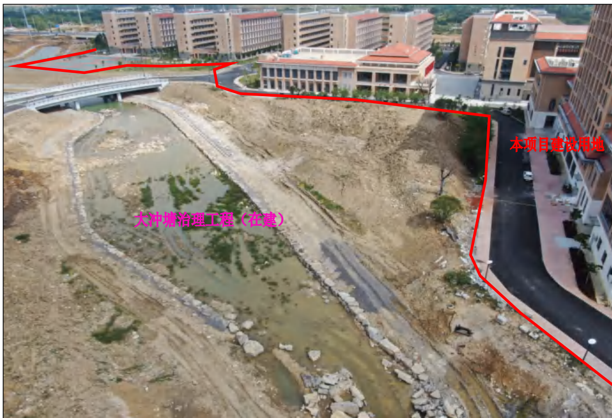
本项目用地与大冲塘治理工程用地衔接处中部现状，大冲塘治理工程现状施工阶段
