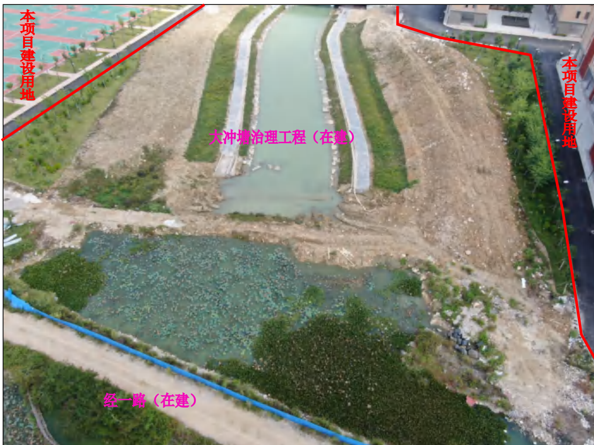
本项目用地与大冲塘治理工程用地衔接处西面现状，大冲塘治理正在施工，现状已完成边坡修整 广西北海水电勘测设计院有限公司
