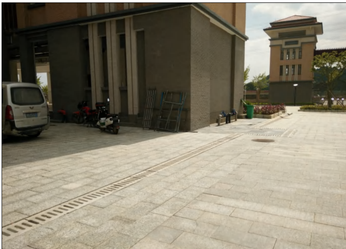
项目用地内排水明沟现状，现状排水效果较好
