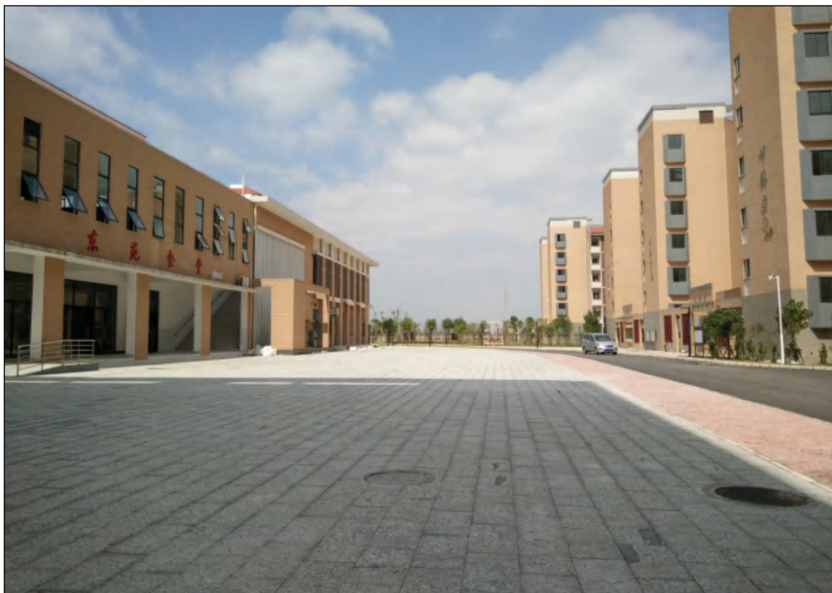
项目用地内硬化铺装工程现状
