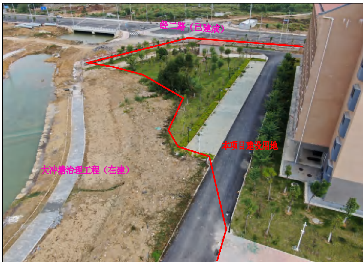
本项目用地与大冲塘治理工程用地衔接处北面现状，大冲塘治理工程现状施工阶段
