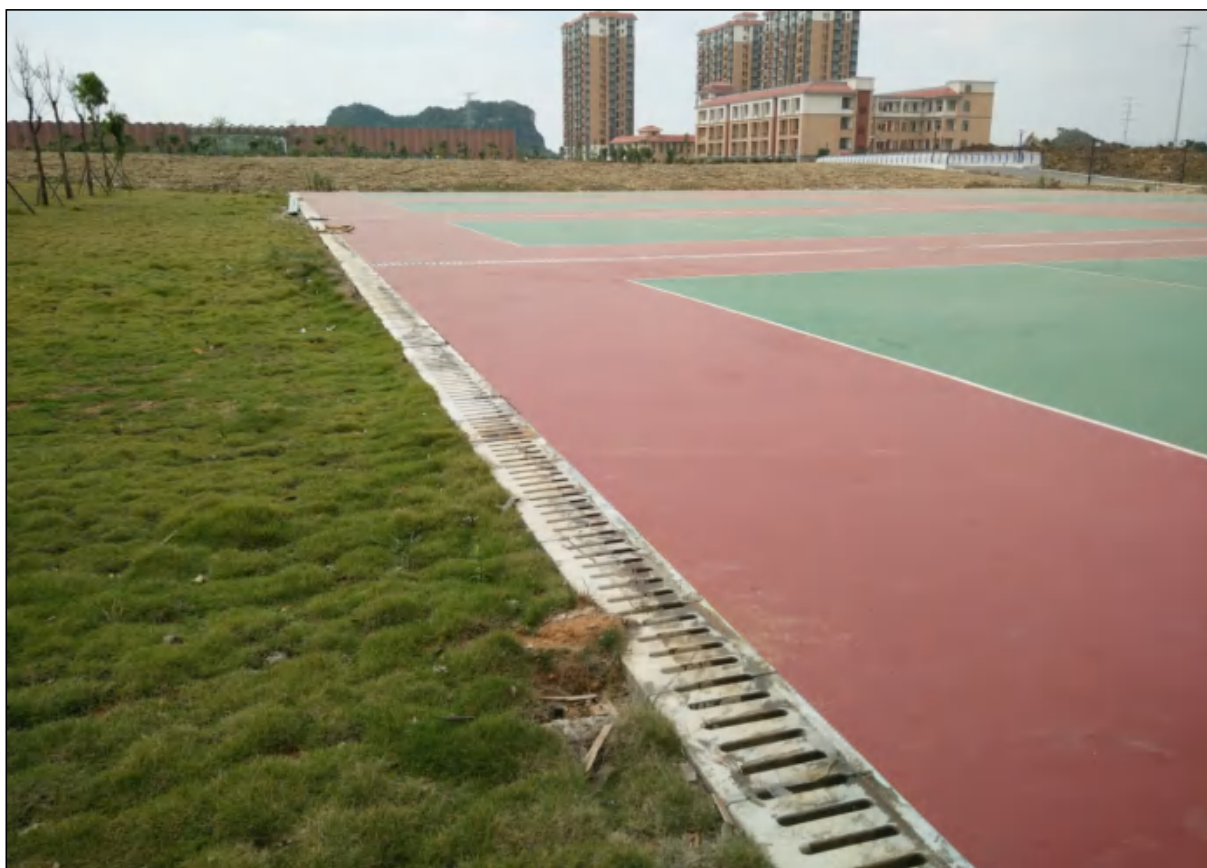
项目用地内排球场四周排水明沟现状，现状排水效果较好
