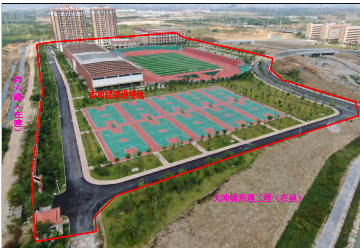
项目用地西北面现状，构筑物、附属设施等已全部建成，植被生长状况较好
