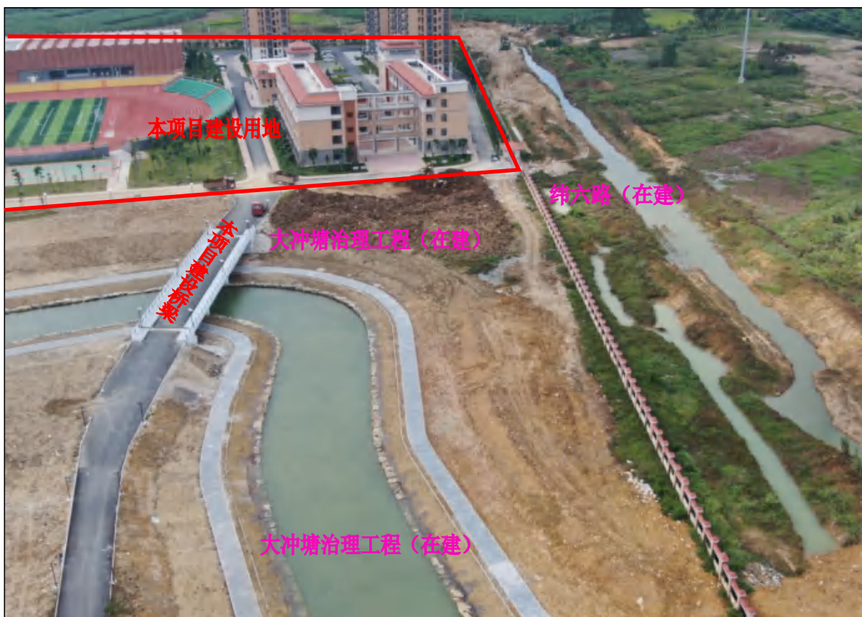
本项目用地与大冲塘治理工程用地衔接处北面现状，大冲塘治理工程现状施工阶段
