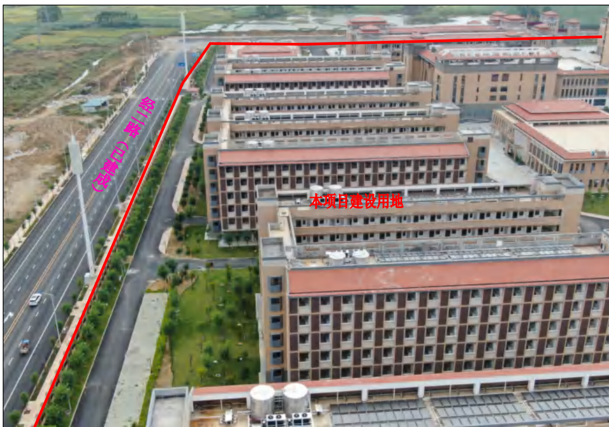
项目用地东北面现状，构筑物、附属设施等已全部建成
