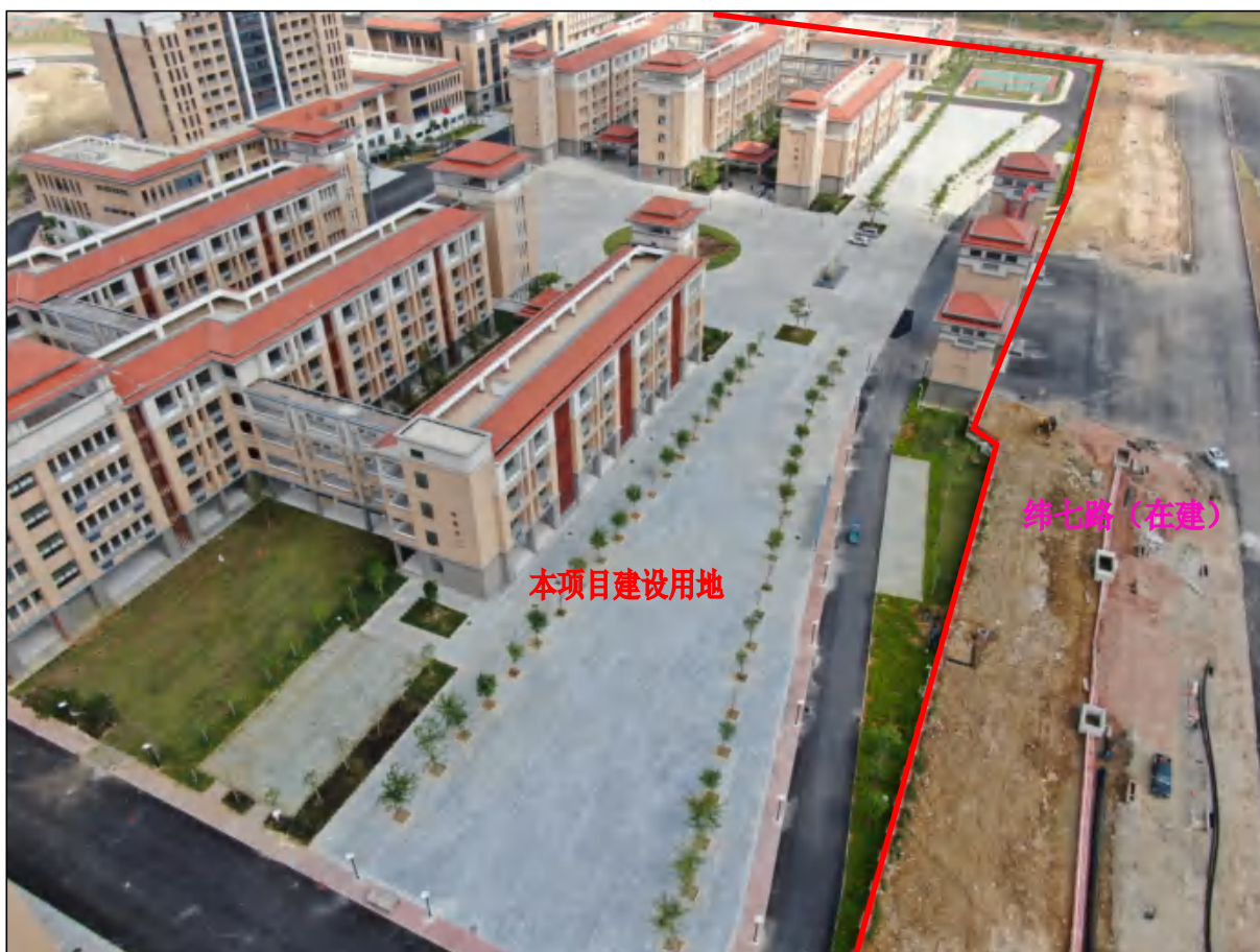
项目用地南面校园大门处现状，构筑物、附属设施等已全部建成
