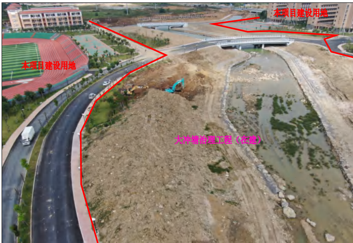
本项目用地与大冲塘治理工程用地衔接处中部现状，大冲塘治理工程现状施工阶段
