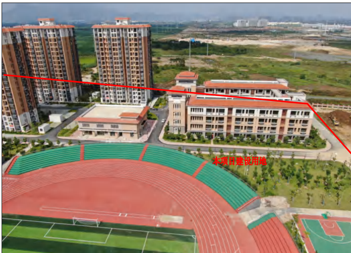
项目用地北面现状，构筑物、附属设施等已全部建成
