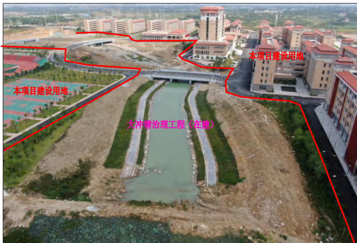
本项目用地与大冲塘治理工程用地衔接处西面现状，大冲塘治理正在施工，现状已完成边坡修整
