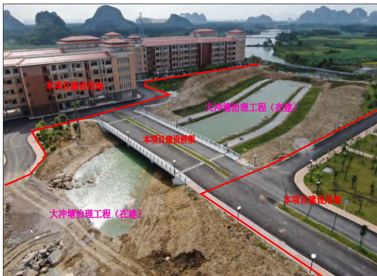
本项目用地与大冲塘治理工程用地衔接处中部现状，本项目建设的桥梁已完工
